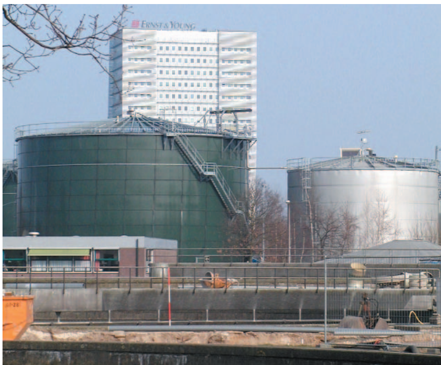
Het nieuwe kantoor van Waterschap Veluwe wordt verwarmd met een warmtepomp, die warmte onttrekt aan het effluent van de RWZI in Apeldoorn.
