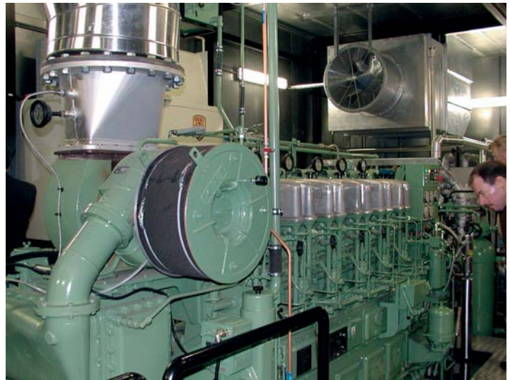
2. Biomassa met motor geschikt voor Biodiesel.
